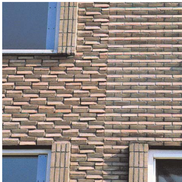
Bij project in Sloten, Amsterdam, pastte Rudy Uytengaak voor het eerst een vormsteen toe. De steen met scheg werd afwisselend met gewone stenen gebruikt in verschillende patronen.
