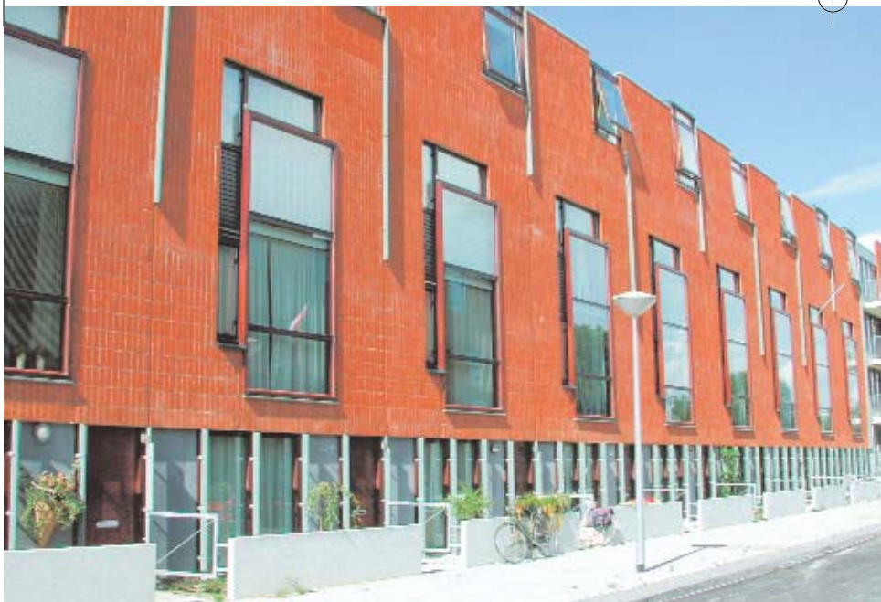
Bij dit woningbouwproject in Hoofddorp (2004) is de functie van het buitenspouwblad opnieuw gedefinieerd en vertaald in een vlak met perforaties. Van een afstand lijkt de steen massief, maar bij benadering verandert het vlak in een vitrage.
