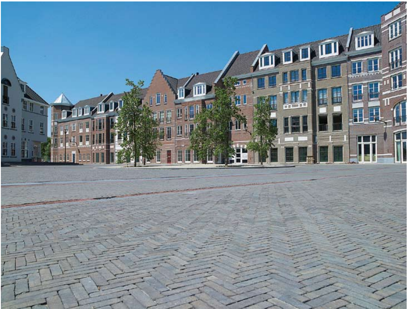
Brandevoort, Helmond: Das typisch holländische Fassadenbild setzt sich in der Pflasterung mit traditionellen holländischen Pflasterklinkern im Waalformat fort. Verwendete Pflasterklinker: Nostalgie WF schwarz-braun
