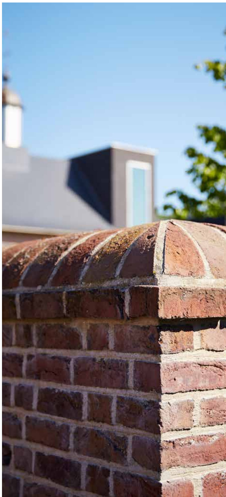
Samenwerking tussen AWG-architecten en Koplamp Architecten, Guido Vancoppenolle, Roeselare
