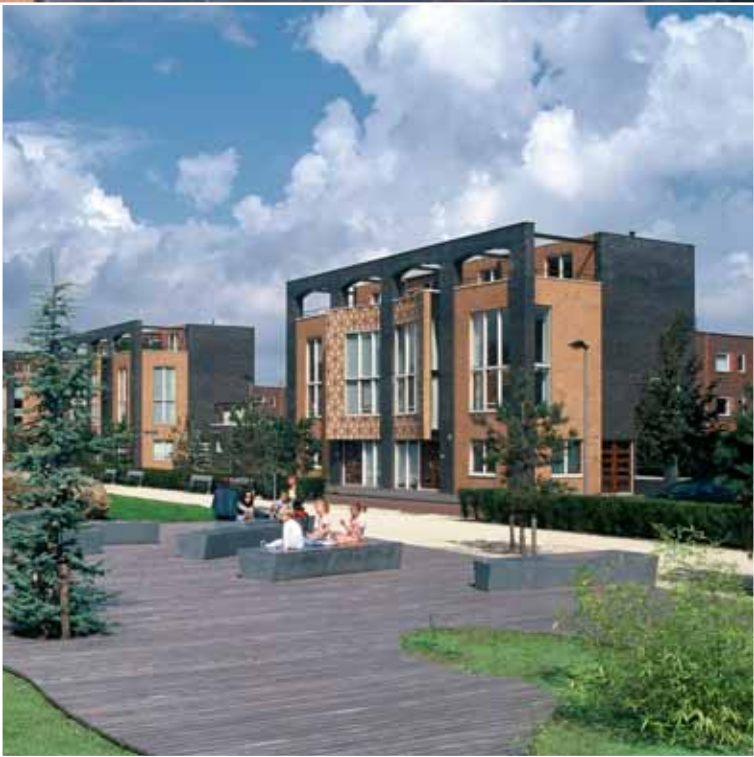
Dat met vorm, kleur en patronen veel sfeereffecten zijn te bereiken, bewijst ook dit woningbouwproject op de Kop van Zuid in Rotterdam: de Stadstuinen aan het Witteveenplein.
