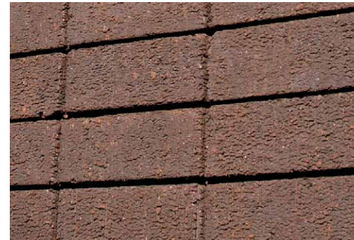
Bij een verlijmde gevel is de voeg erg fijn.
