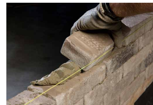
Omdat de overtollige mortel gemakkelijk weg kan, kunnen de stenen zonder veel correctiewerk uiterst precies worden geplaatst.
